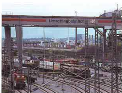
Der neue Umschlagbahnhof Weill auf der deutsch-schweizerischen Grenze.
